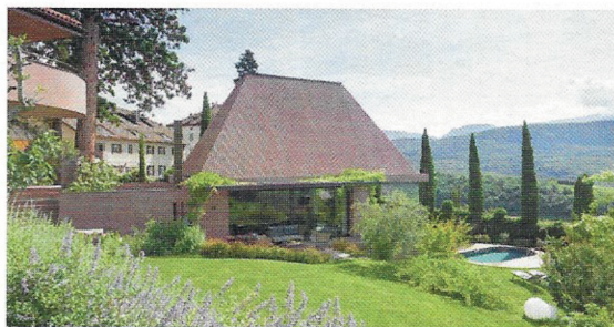
Villa Baronessa in Kaltern, Arch. Walter Angonese mit „Schiefer Tschöll Architektur“, Manfred Alois Mayr (künstlerische Intervention) und Roland Dellagiacomma (Landschaftsarchitektur)
