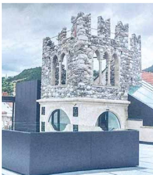
• Particolare del restauro del Municipio di Bressanone
