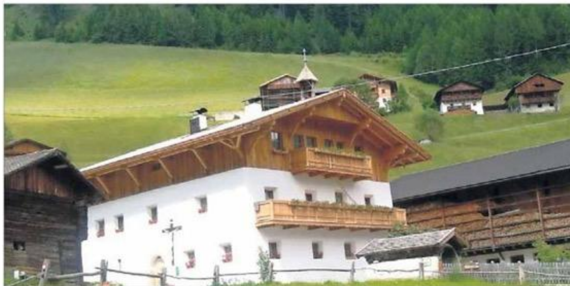
Für die Sanierung des Obergasserhauses in Pfunders gab es den Anerkennungspreis.
