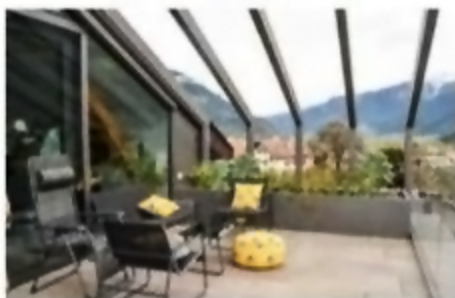
Stahlträger erinnern noch an die ursprüngliche Form des Daches beim Haus Gamper in Göflan (Arch. Julia Pircher)
