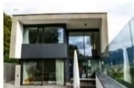
Eine Schallschutzwand aus Beton und rahmenlosem Glas schützt das Wohnhaus G. in Schlanders vor Straßenlärm (Arch. Stephan Marx)
